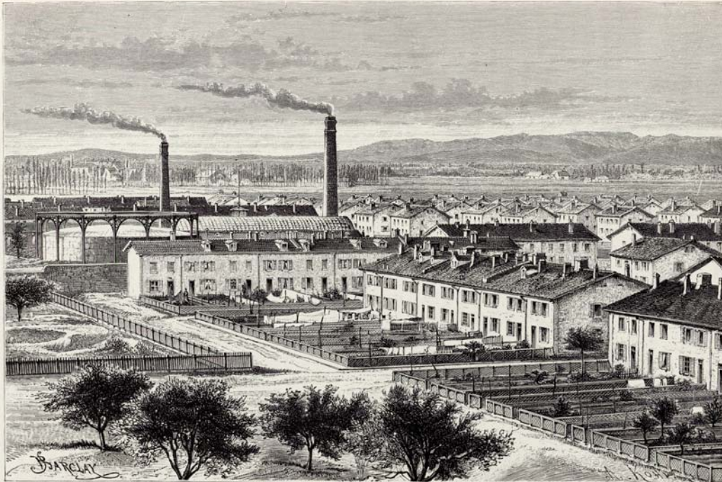
VEU GÉNÉRALE DES CITÉS OUVRIÈRES DE MULHOUSE.
