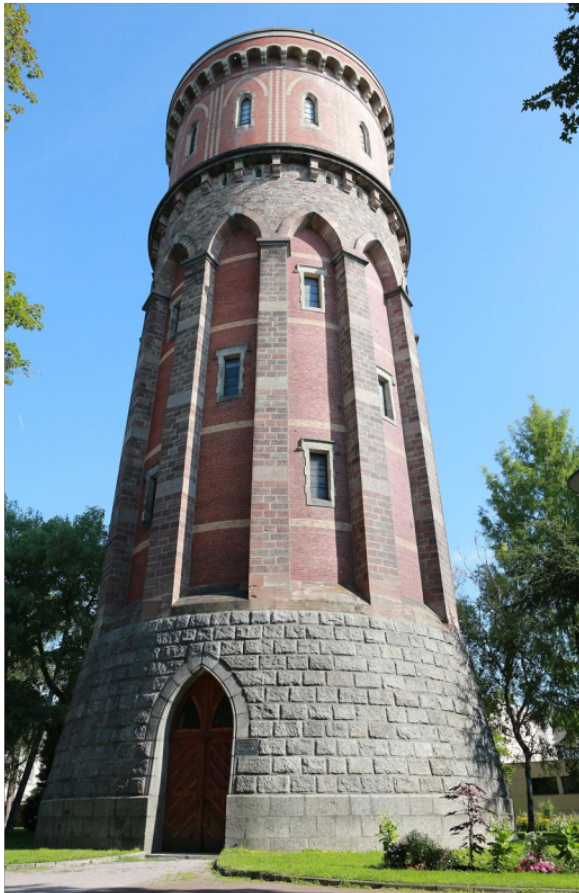
À l'exception de sa toiture, qui a été remplacée en 1961 par un revêtement en cuivre à plus faible pente, le château d'eau est inscrit aux monuments historiques depuis 1993. PHOTOS L'ALSACE - CHRISTELLE DIDIERJEAN
