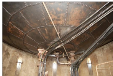
D'une capacité de 1 250 m 3 , le réservoir de neuf mètres de haut, dispose d'un fond bombé en tôle de 15 millimètres d'épaisseur et de 12 mètres de diamètre.
