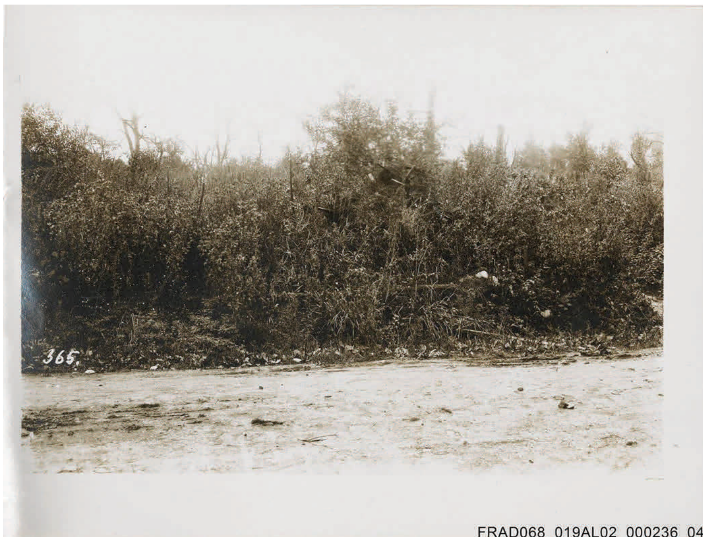
Photographie de la maison du berger d'Ammertzwiller dans les années 1920. AD68 19 AL 2/236.
